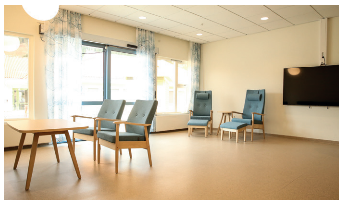
Fra en fellesstue i Vik helse- og omsorgssenter. Materialer er vinylbelegg på gulv, malt gips på vegger og systemhimling.
