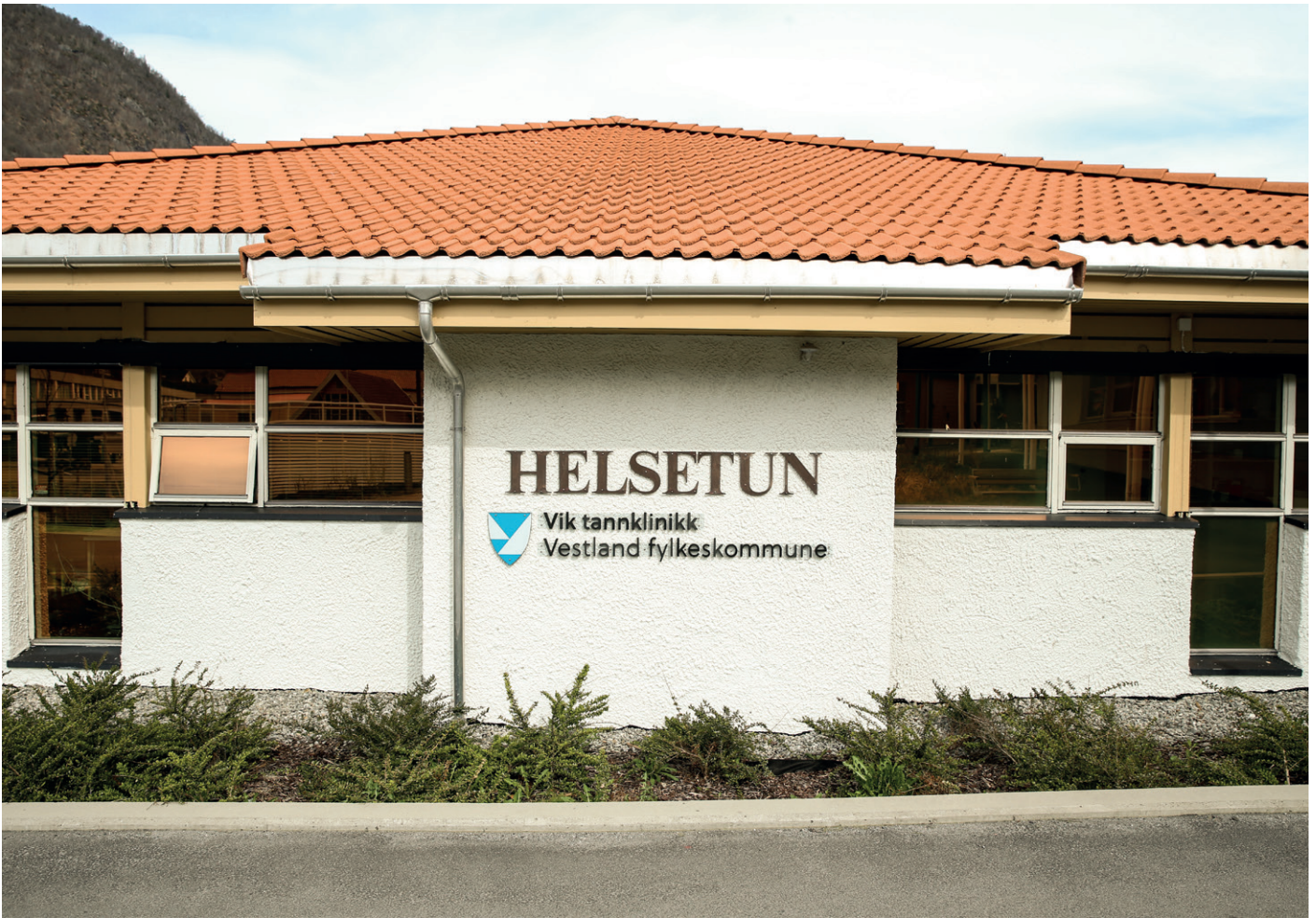
Vestland fylkeskommune er leietager med tannklinikk i bygg B. Dette bygget er en ombygging og utviding av helsetunet med lege- og tannlege-tjenester og ny ambulansetilkomst.
