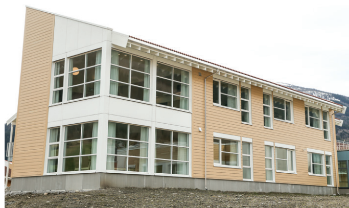
Bygg E inneholder seks omsorgsboliger og seks sykehjemsrom. Dette er et av de store nybyggene med stål og hulldekker som bærende konstruksjoner.
